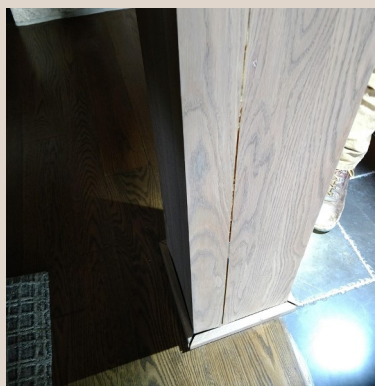
Split edge glued column wrap
